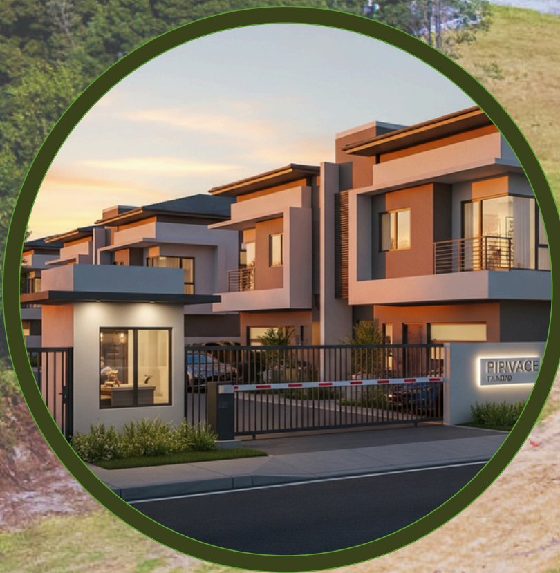
Portón de seguridad
